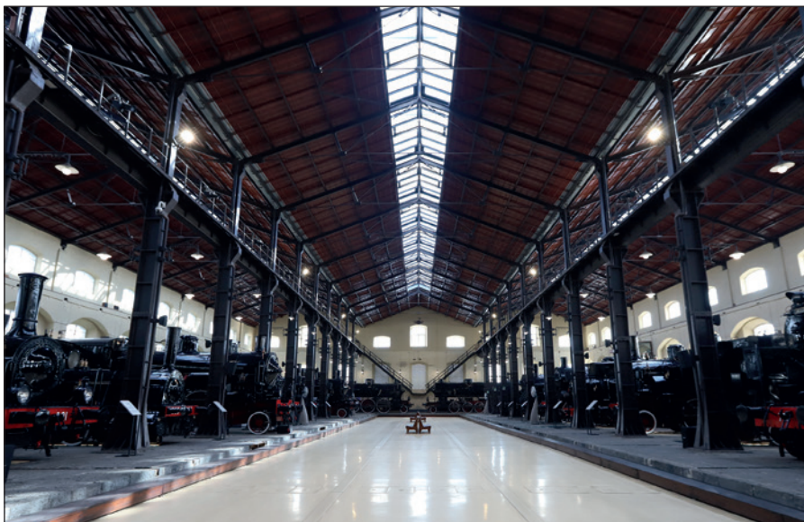
Il grande padiglione che ospita le locomotive a vapore. © Archivio Fondazione FS italiane.
